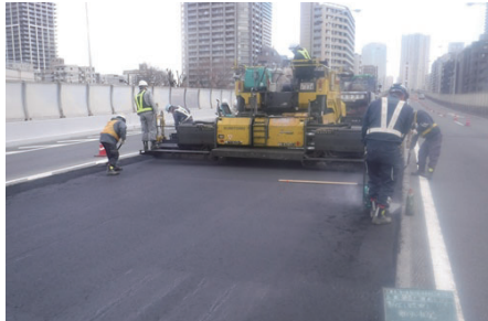
施工手順その1：舗装をキレイにする。
